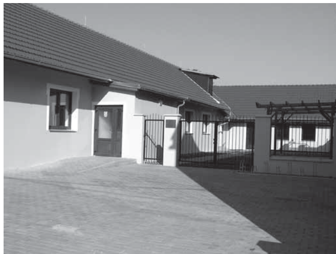
Foto po realizaci
