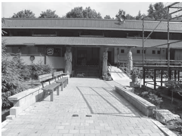
Foto po realizaci
