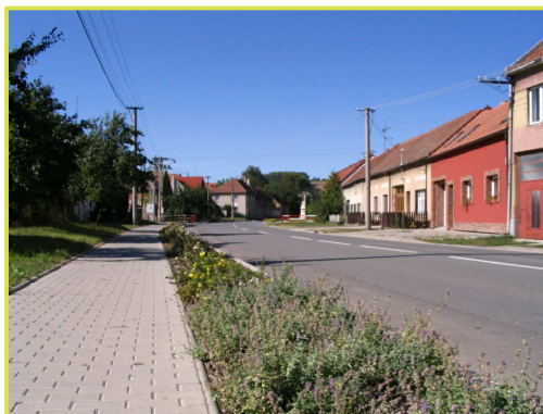
Foto po realizaci
