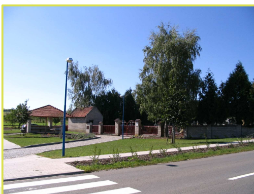
Foto po realizaci
