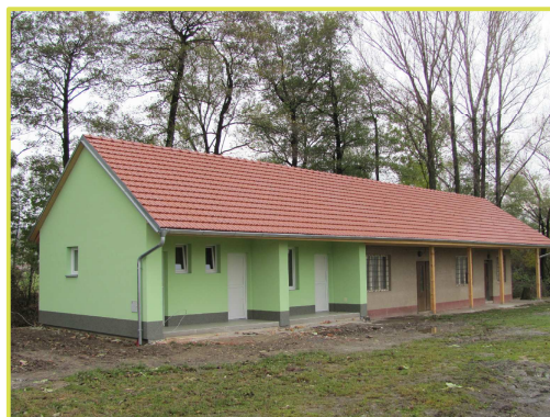
Foto po realizaci
