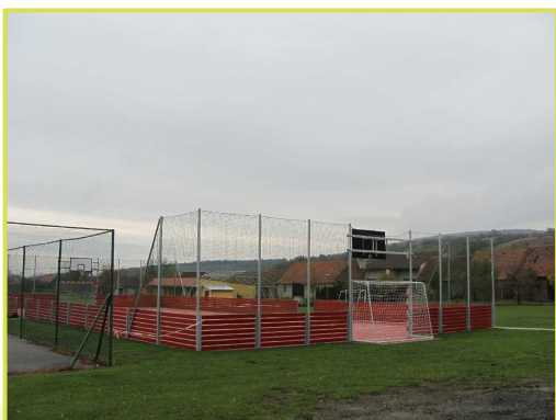
Foto po realizaci
