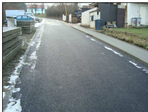
Foto po realizaci
