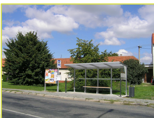
Foto po realizaci
