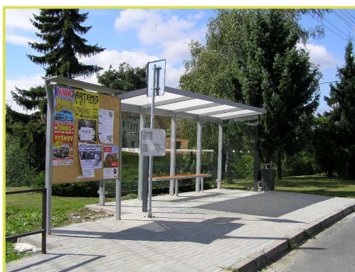
Foto po realizaci
