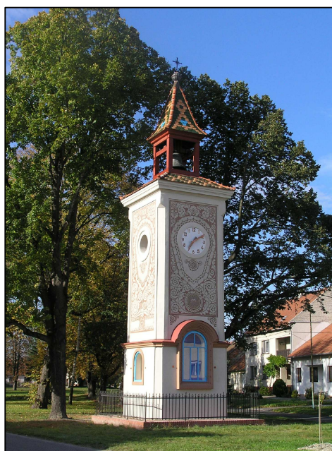
Foto po realizaci
